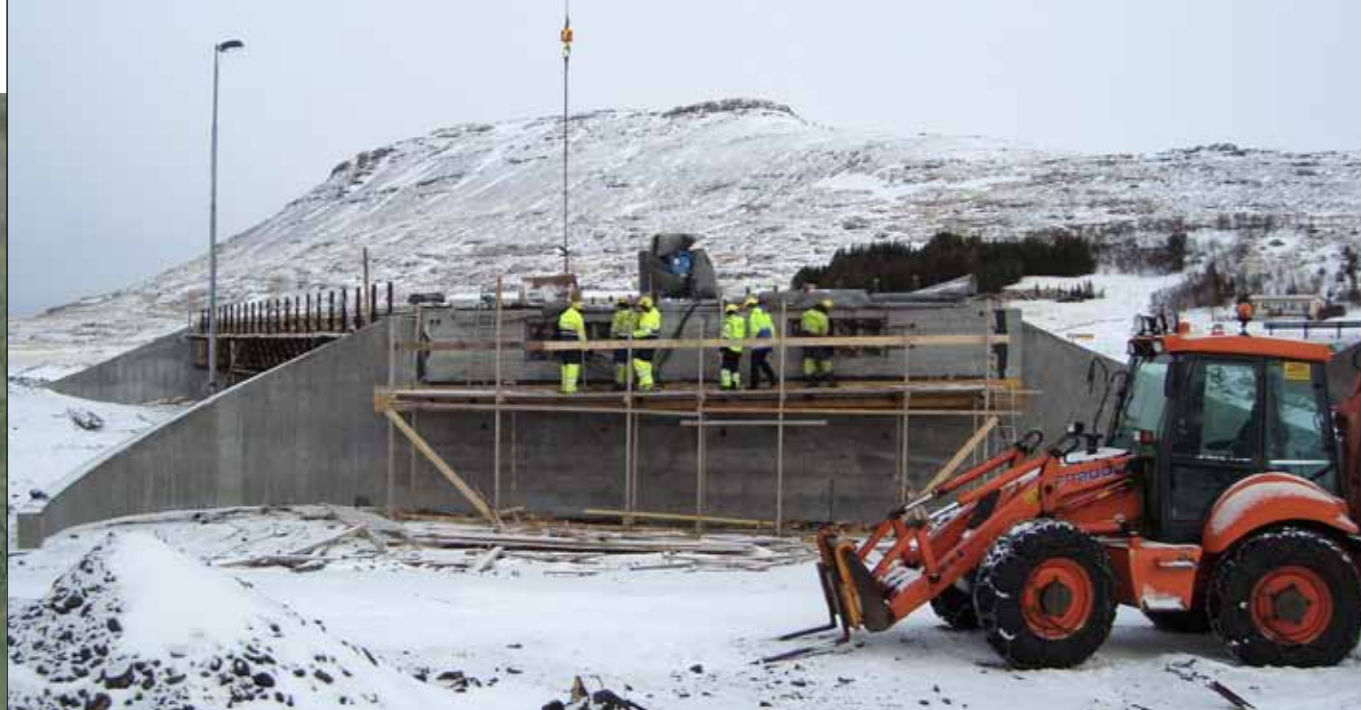
Ný brú á Reykjadalsá í byggingu 19. mars 2014. Verið er að spenna upp bita brúarinnar. Það var brúavinnuflokkur Vegagerðarinnar frá Hvammstanga sem byggði brúna. Hér í opnunni er birt auglýsing um útbod á tengingu brúarinnar.
