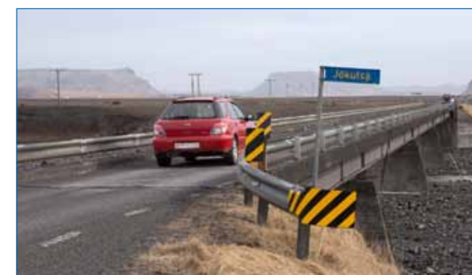
Sólheimasandur 2013. Vestari landstöpull gömlu brúarinnar frá 1921 stendur eins og minnismerki á sandinum. Brúin frá 1967 stendur aðeins neðar en gamla brúin. Hún er einbreið, sú eina á Hringveginum á Suðurlandi allt austur fyrir Kirkjubæjarklaustur. Þar er fyrst Breiðbalakvísl (Geirlandsá) 166 m löng einbreið brú og nokkrar fleiri einbreiðar brýr enn austar. Rétt er að geta þess að núverandi bráðabirgðabrú yfir Múlakvísl, rétt austan við Vík, er einbreið. Það er mikill ókostur að brúin yfir Jökulsá á Sólheimasandi sé einbreið því ökumenn, sem þekkja ekki til, gera ekki ráð fyrir þrengingu vegarins á þessu svæði. Þarna er því talsverð slyshætta í gildandi samgönguáætlun er gert ráð fyrir fjárveitingum til breikkunar brúa á Suðurlandi á tímabilinu 2019-2022. Gera má ráð fyrir að Jökulsá verði þar framfarlega í röðinni.
