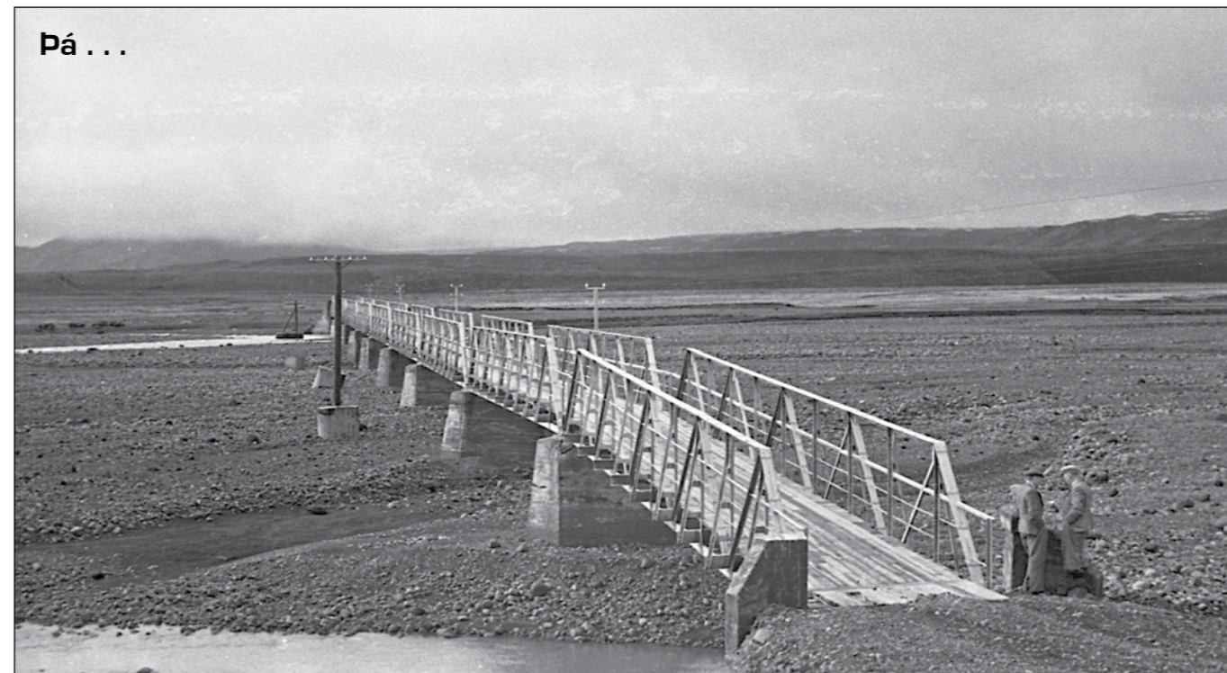
Jökulsá á Sólheimasandi. Þessi brú var byggð 1921. Í bókinni „Brýr að baki“ er ítarleg frásögn af gerð þessarar brúar og sögu hennar. Myndin er líklega tekin 1946 en árið áður hafði grafið undan eystri landstöplinum. Þrátt fyrir ýmis áföll var þessi brú í notkun allt þar til ný brú var byggð 1967.
